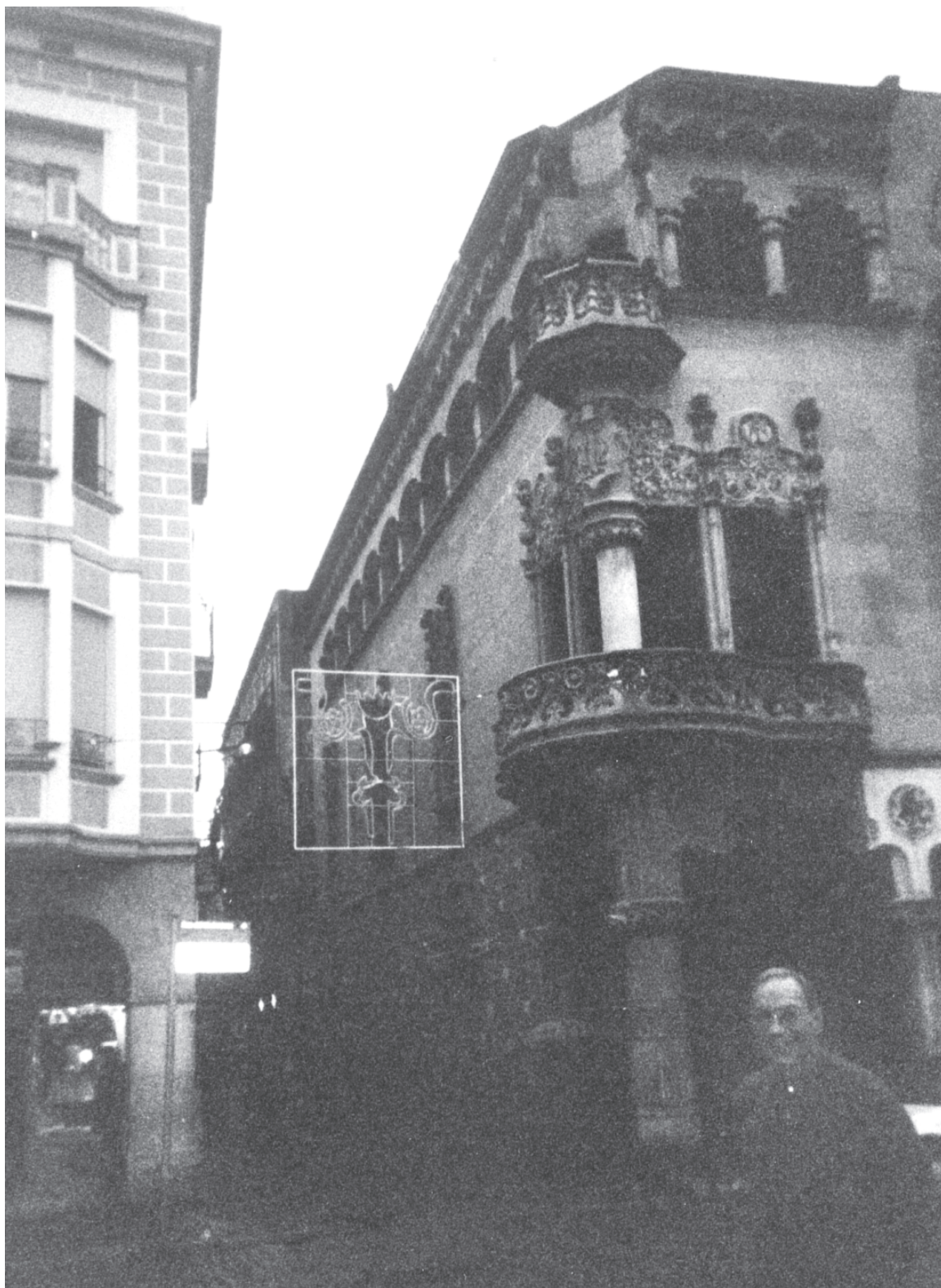
Fachada lateral de la Casa de Navas.
