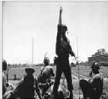
Fotografía tomada en el Hotel El Coloso.
